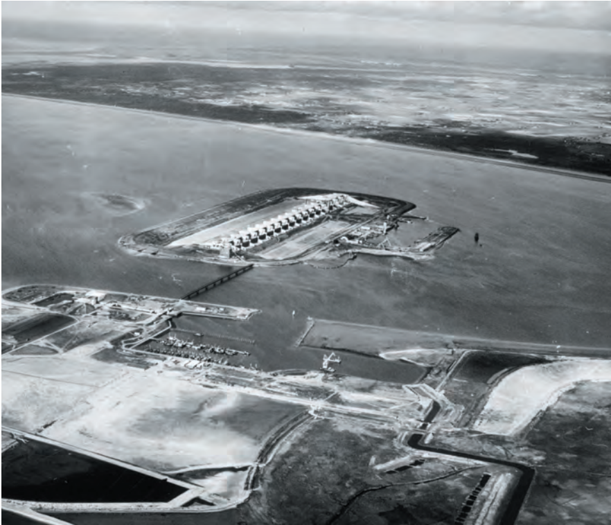
Aanleg van de Haringvlietdam met spuisluizen tussen Voorne-Putten en Goeree-Overflakkee, als onderdeel van de Deltawerken, Anefo, 15-11-1965. Nationaal archief
